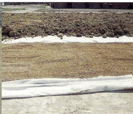
Foto 2 - Fase di cantiere: si possono osservare i diversi costituenti del sistema suolo predisposto, così come descritti nel testo.
