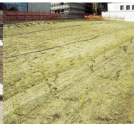
Foto 3 - Fase di cantiere: particolare del telo pacciamante, del sistema di irrigazione e della piantagione d'arbusti appena effettuata.
